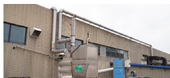
车间粉尘滤筒（布袋除尘器）收集
